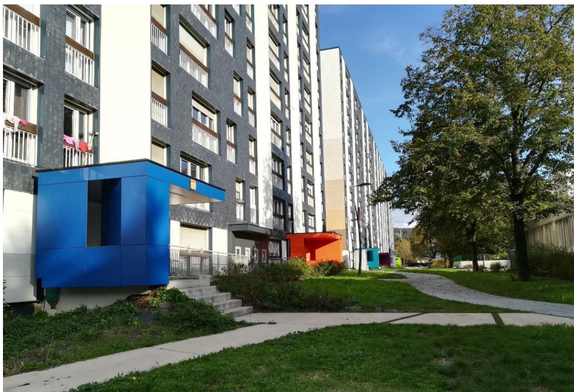
Vue des réaménagements des entrées d'immeubles gérés par Alpes Isère Habitat Photo Agence, septembre 2019
